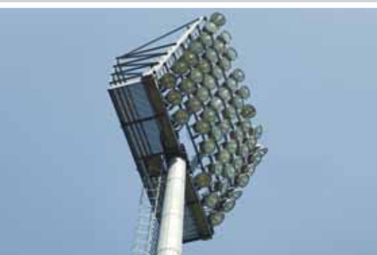
I pali galvanizzati d'illuminazione di Galva Coat misurano da 4 m a 20 m.
